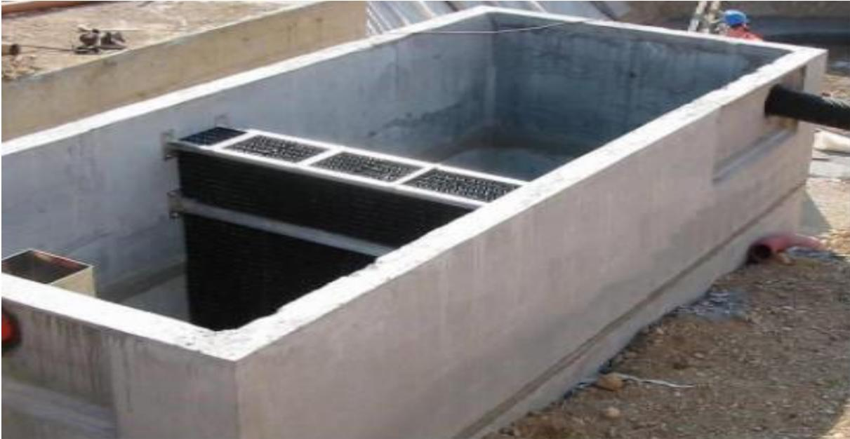
Nuestros separadores de hidrocarburos están fabricados en PRFV (Poliéster Reforzado con Fibra de Vidrio), y en concreto en obras. Son compuesto de un desarenador y filtros coalescentes de alto rendimiento. Según modelo y necesidades del proyecto y del cliente, pueden llevar también By-Pass y sistema de recogida de hidrocarburos externo (skimmer) con depósito de recogida y accesorios.
